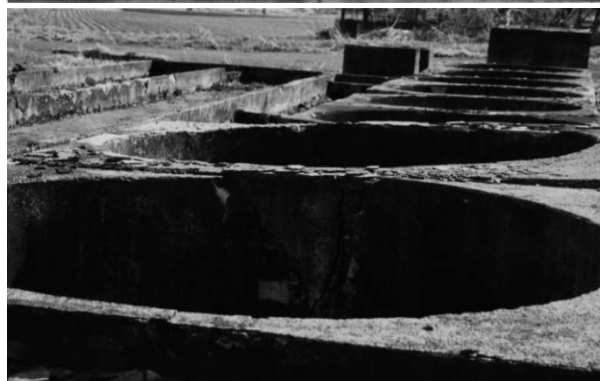
上の写真は、水車動力の台座の上に碑が。下の写真は、左側が流下沈殿槽、円形が澱粉分離の溶解槽。
